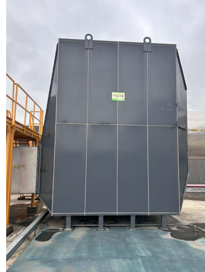
图 2-7.10 B 栋低浓度有机废气治理设施-三级干式过滤器
