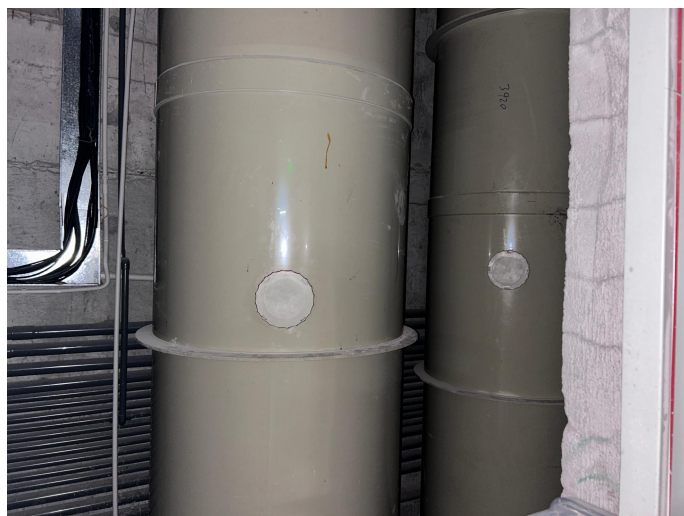
图 2-7.31 污水处理厂废气收集管道
