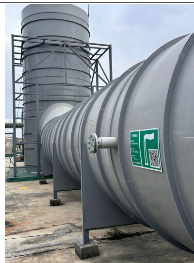
图 2-7.30 C 栋一般酸雾废气排放口 (FQ-008784)
