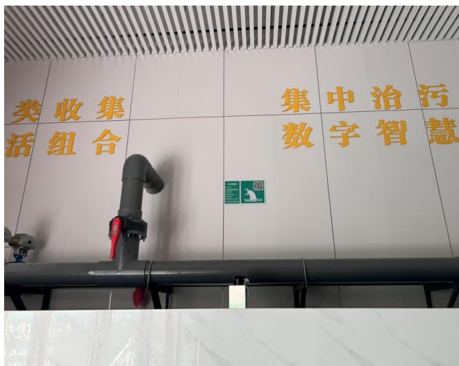
图 2-7.51 生产废水排放口 (WS-003333)
