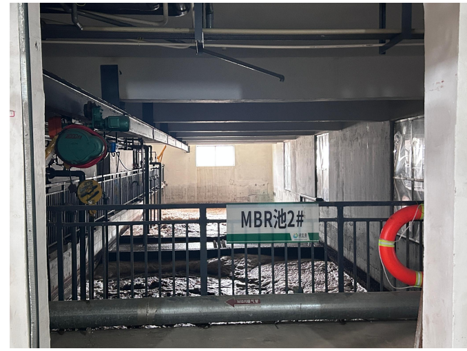
图 2-7.48 污水厂废水综合治理设施（MBR 膜处理）
