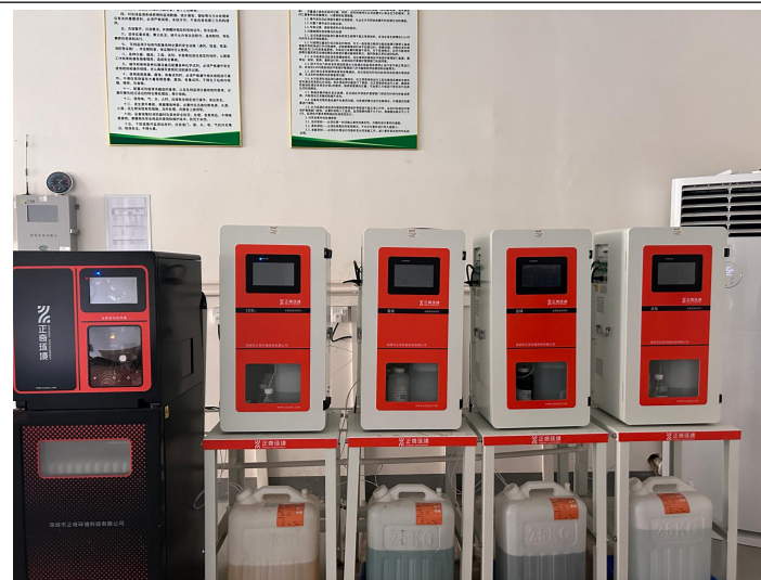
图 2-7.51 生产废水排放口 (WS-003333) 在线监控设备
