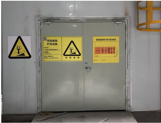
图 2-7.54 项目危险废物暂存间 (GF-010115)
